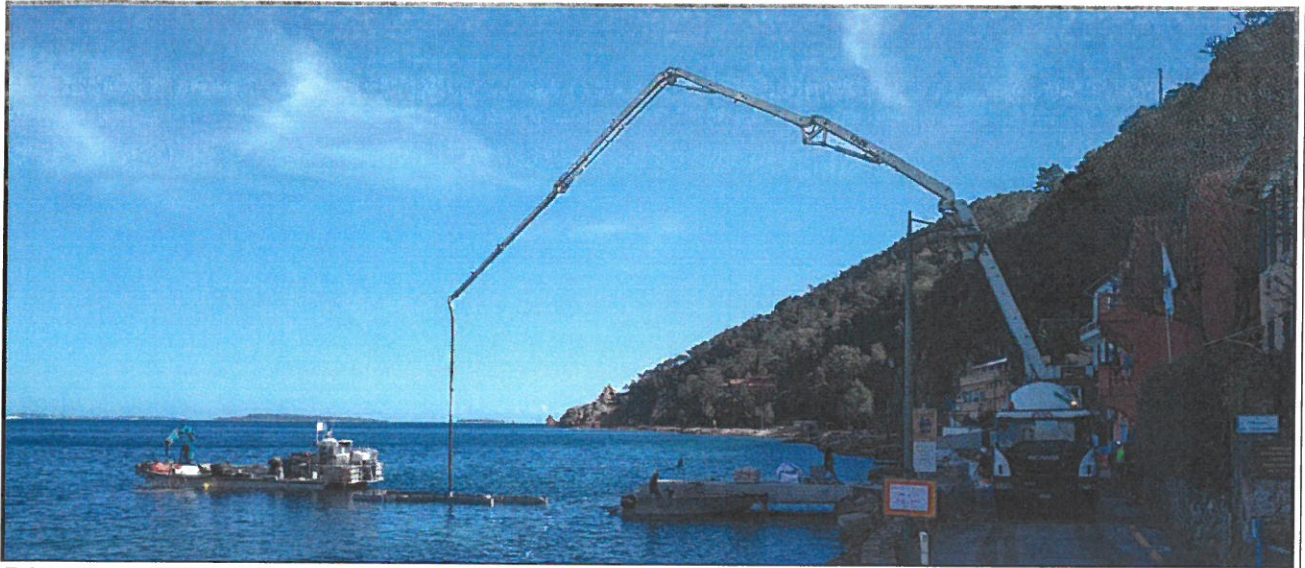
Bétonnage de la pile depuis la route
